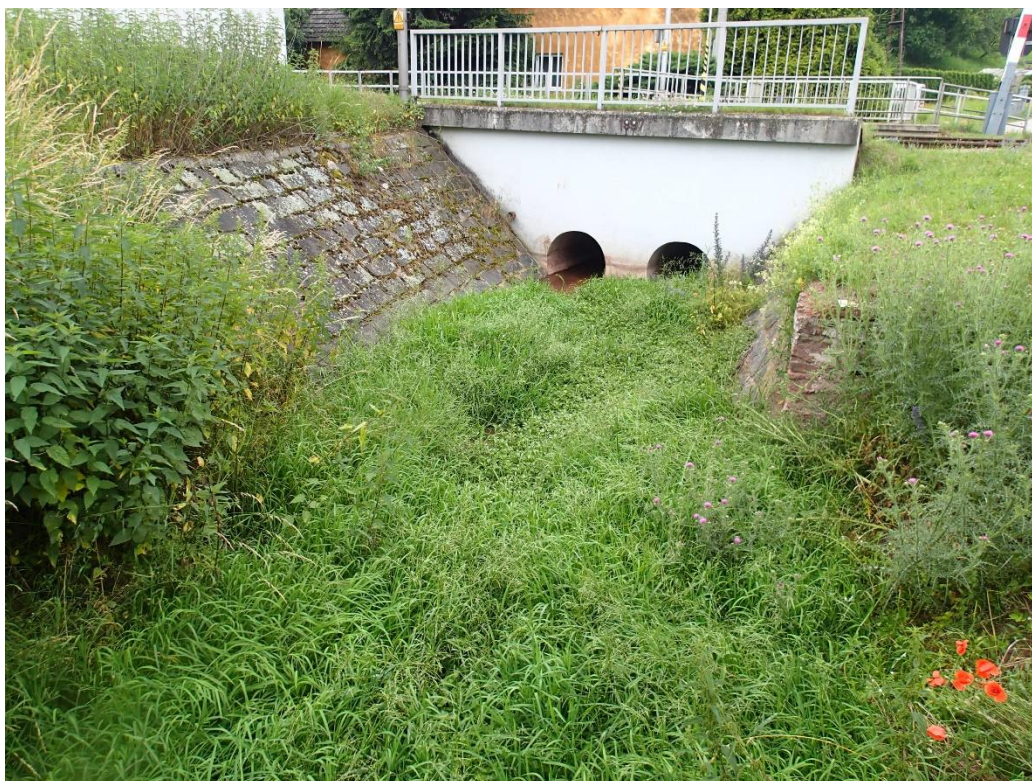
Pohled na propust pod železniční trať. Začátek upravovaného úseku koryta toku (km 0,160).
