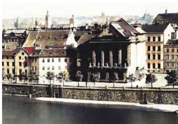
... a skutečná stavba
