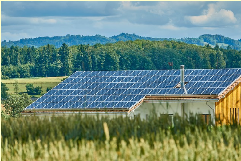
Střešní fotovoltaika, využití místního bioodpadu a větru pomáhá k decentralizaci
