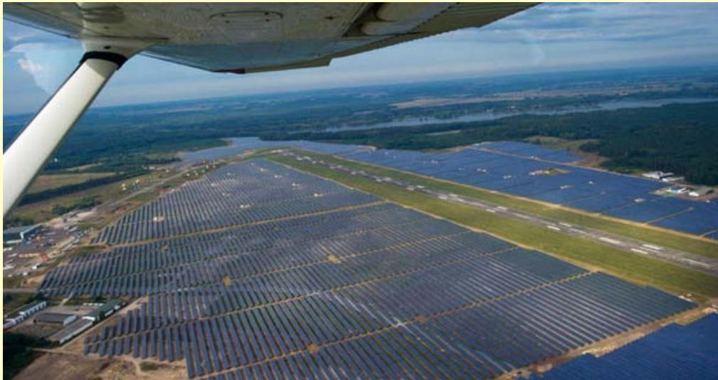
Německá sluneční elektrárna Neuhardenber má 148 MW
