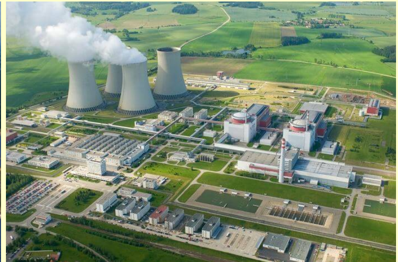
Jaderná elektrárna Temelín
