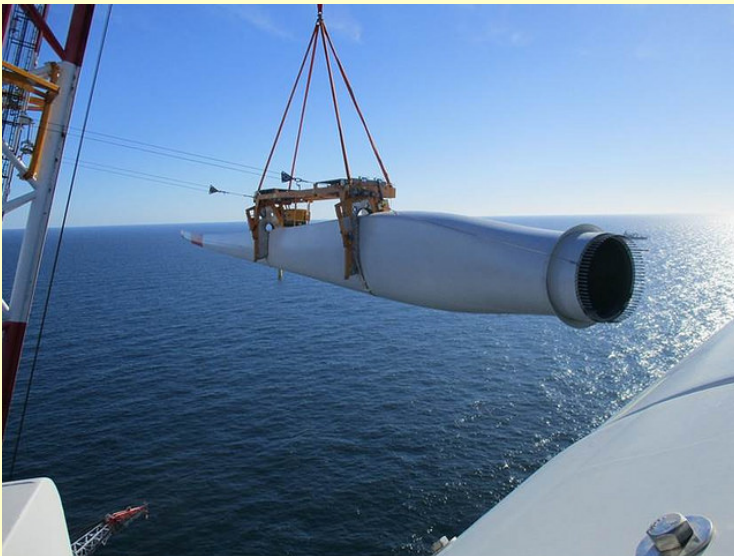
Instalace mořské větrné turbíny
